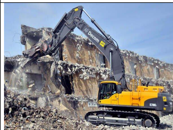
Figur 27. Gravemaskin med betongknuser
