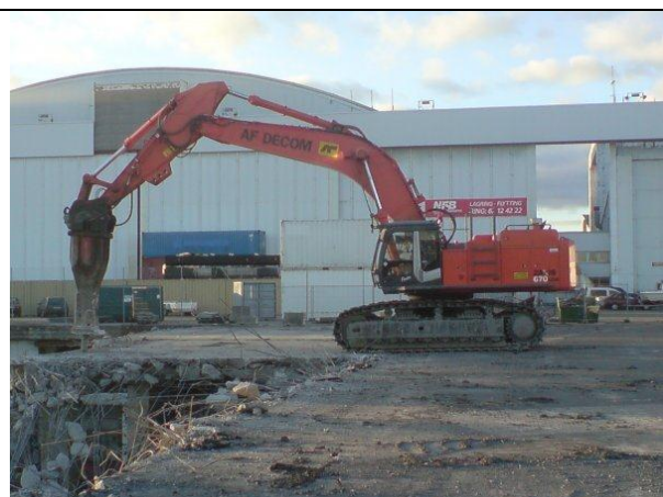
Figur 26. Gravemaskin med hammer
