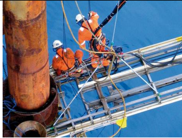
Figur 34. Arbeide med wiresaging offshore
