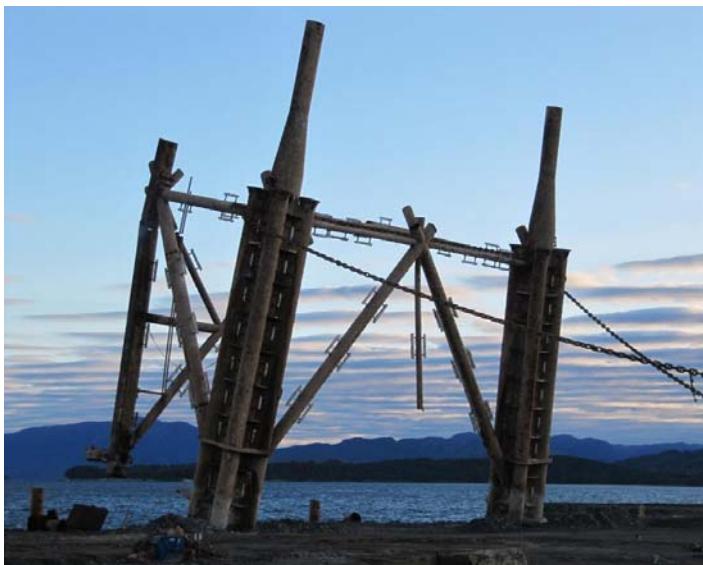
Figur 8 Velting av stålunderstell på Aker Stord
