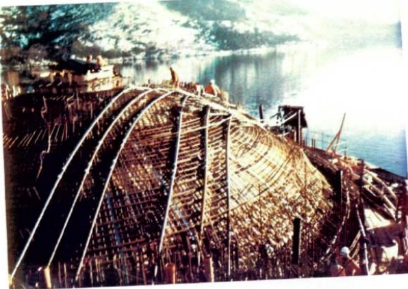
Figur 9 Armering øvre kuleskall [13].
